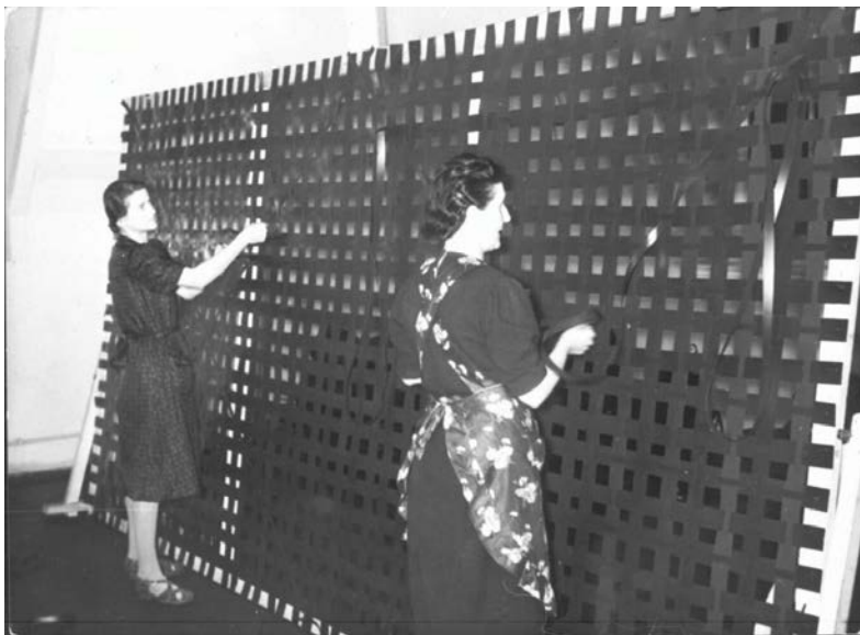
Afb. 9. Vervaardiging van zgn. 'Tarnmatten', de uitsparingen zijn bedoeld om daar takken met bladeren of heide in te steken. De matten werden gebruikt om vliegvelden te camoufleren. Collectie NIOD
