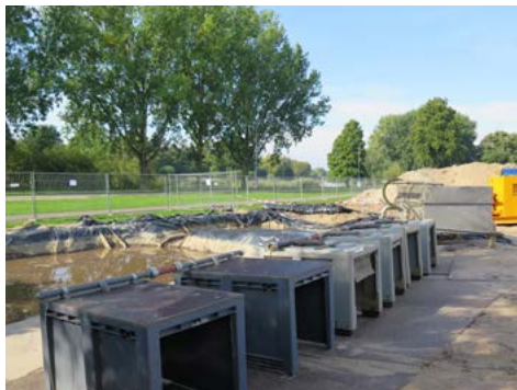
Afb 6 – Vanwege de sterk zandhoudende bodem werd in de Oostflank Wijchen gebruik gemaakt van deze zeefinstallatie. Foto: Jan Jansen
